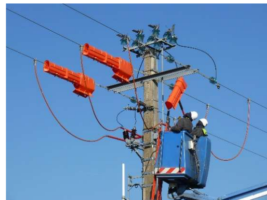
Coupure du réseau en amont et mise à la terre par sécurité (hors tension)
