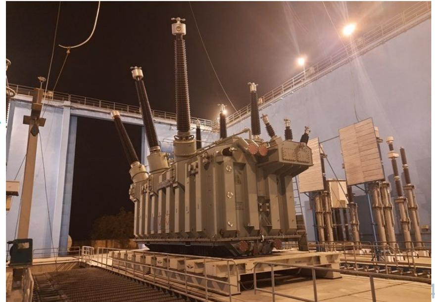
Toutefois à puissance équivalente, l'autotransformateur sera moins cher (un enroulement en moins par phase) plus petit et plus léger (circuit magnétique). Ceci mène à une inductance de fuite et des pertes Joule et fer plus faibles.
