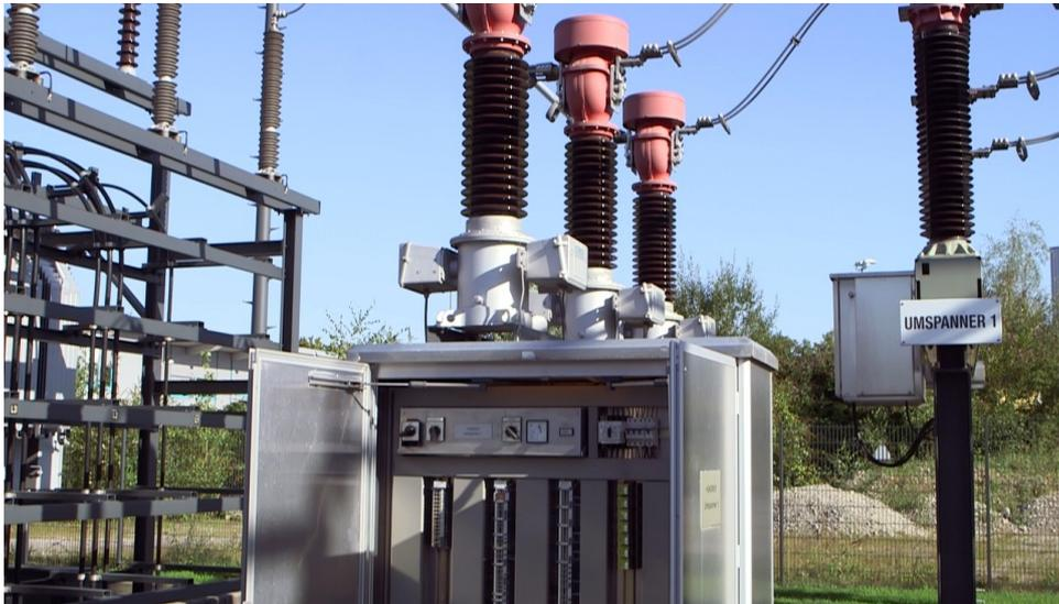
Transformateur de courant utilisé en HT
