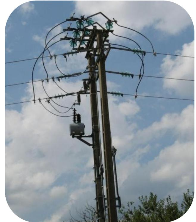
L'Interrupteur MSS (Merlin Soulé Simplex) remplit les mêmes fonctions qu'un IAT. Cependant l'interrupteur est réalisé dans une cellule située en tête de poteau. Il remplace l'IAT classique.
