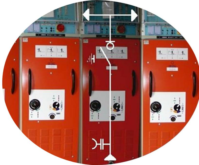
On trouve également des cellules combinant interrupteur, sectionneur et fusible.
