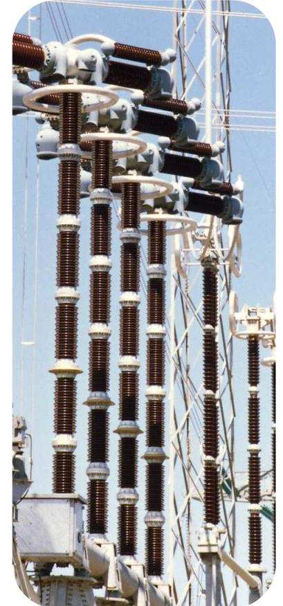
Disj. à air comprimé 3-52
