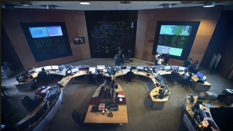
Centre de contrôle
