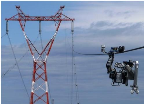
Travail au potentiel. Exemple de robot Linescout de Hydro-québec en service (sous tension)
